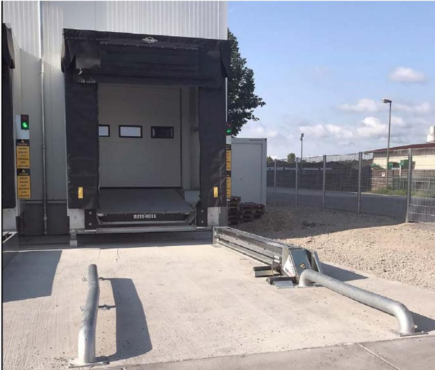
Abb. 1: Wheel-Lok®-System mit Einfahrhilfen im Vordergrund und Ampelsteuerung (Q: Rite-Hite)
